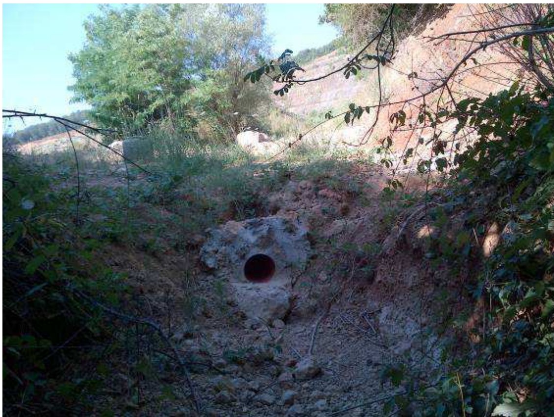
Fig. 8.1 – Punto di immissione della vasca di tipo C sul compluvio (stato Luglio 2015)
