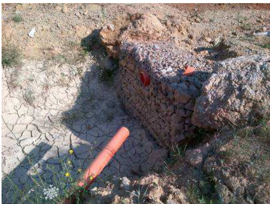
Fig. 7.1 – Documentazione fotografica vasca di sedimentazione esistente
